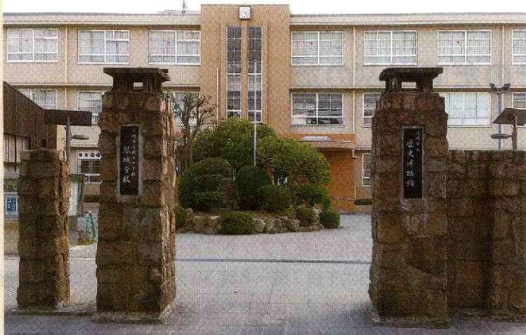
旧校門は、現在は門としての機能はありません。旧校舎は歴史博物館への改修工事に際して、竣工当時の外観にできるだけ戻すようにしました
